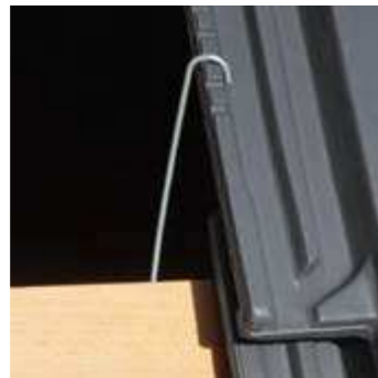
Die Fixierungskerben für die Sturmklammern.
